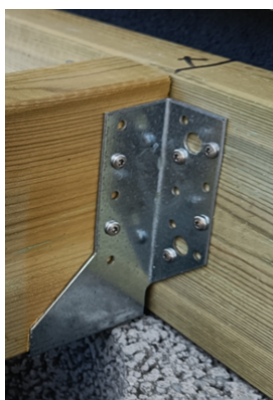
Palkkikenkä Kiinnitys 8+4 kpl 4x40 ankkurinaulaa
