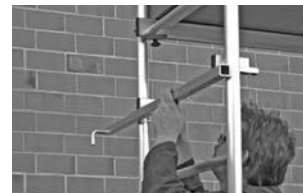
Grunnstillas med første og andre tilbygget
