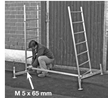
Perustelineet yhdellä lisäkerroksella
