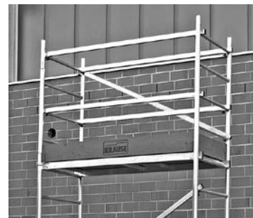
Grunnstillas med første tilbygg
