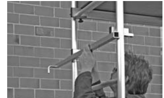
Perustelineet yhdellä lisäkerroksella
