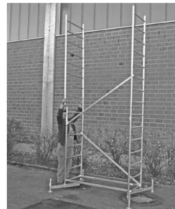
Grunnstillas med første tilbygg
