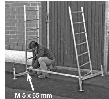
Grunnstillas med første tilbygg
