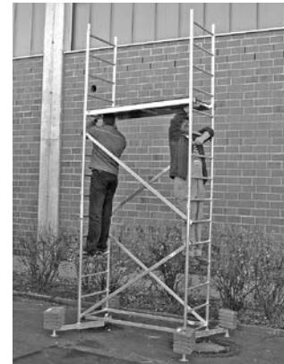
Perustelineet kahdella lisäkerroksella
