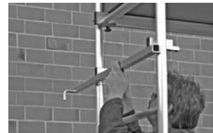
Grunnstillas med første tilbygg
