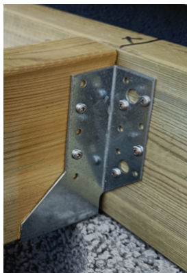
Palkkikenkä Kiinnitys 8+4 kpl 4x40 ankkurinaulaa
